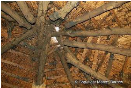
სურ. 2. ლითონის ხანის საცხოვრისის გადახურვის სტრუქტურა
