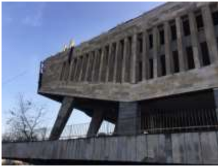
სურ. 8 2020 წლის 23 თებერვალს გადაღებულ ფოტოზე ცხადად ჩანს, რომ კონსოლის პარაპეტზე არსებული ბარიელიფი საბოლოოდ განადგურდა
