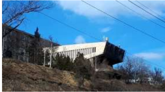
სურ. 8 2020 წლის 23 თებერვალს გადაღებულ ფოტოზე ცხადად ჩანს, რომ კონსოლის პარაპეტზე არსებული ბარიელიფი საბოლოოდ განადგურდა
