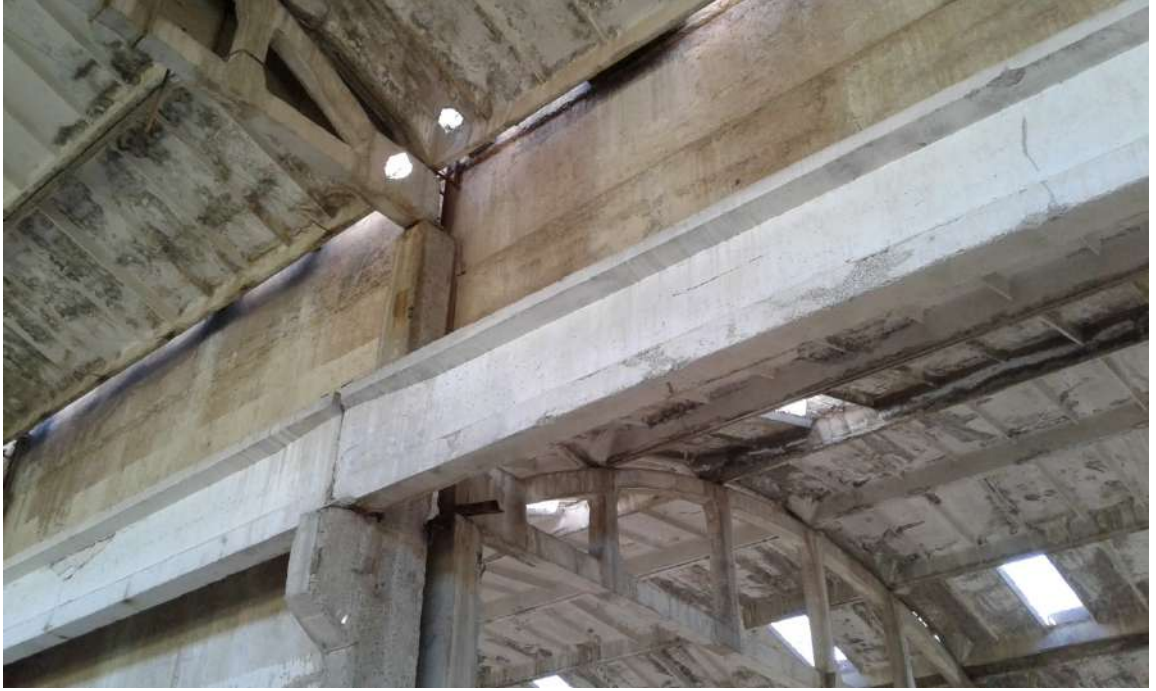
სურ. 5. დემონტაჟს გადარჩენილი ამუქვეშა კოჭი.
